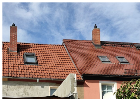
Abb. 49: Bestehende Dachflächenfenster im Geltungsbereich © BCE
