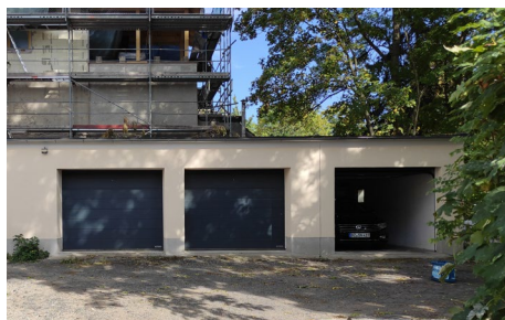
Abb. 57: Garagen als Gemeinschaftsanlage © BCE
