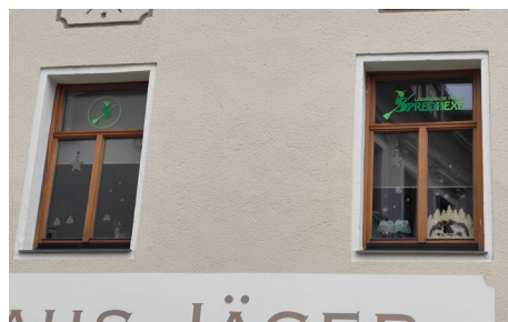
Abb. 66: Beispiel einer nicht störenden Werbeanlage auf einer Fensterfläche © BCE
