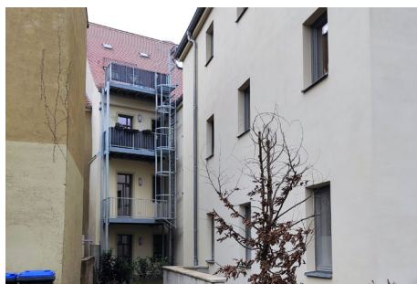
Abb. 39: Zulässige Balkone auf der rückwärtigen, vom Straßenraum nicht einsehbaren Seite © BCE
