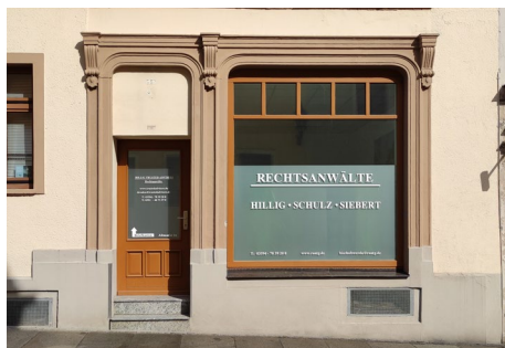
Abb. 29: Brüstungshöhe eines Schaufensters im Stadtbild © BCE
