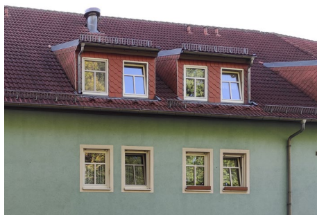
Abb. 46: Material und Farbe der Dacheindeckung © BCE
