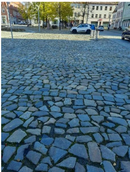
Foto 11: Kopfsteinpflaster (mit breiten Fugen)
