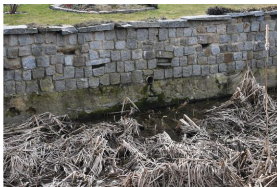
Schäden an der Teichmauer
