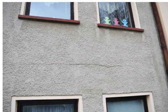
Risschäden Außenwände
