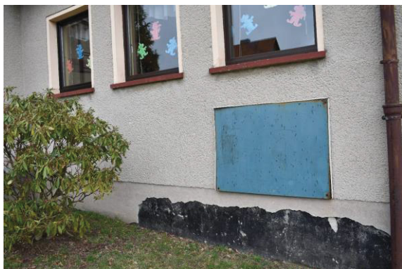
Schäden am Sockel
