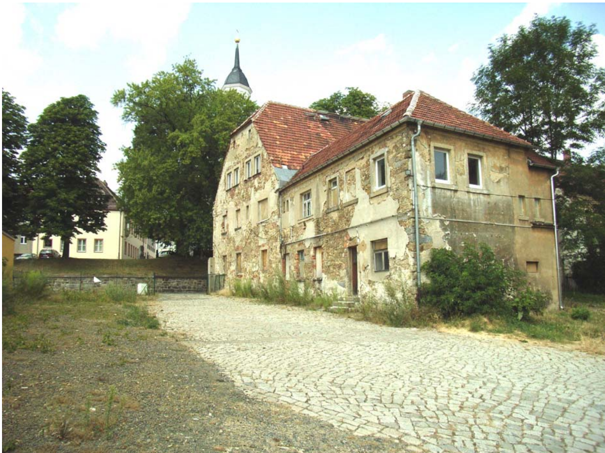
Bild 1: Foto des Gebäudes (Hofansicht)
